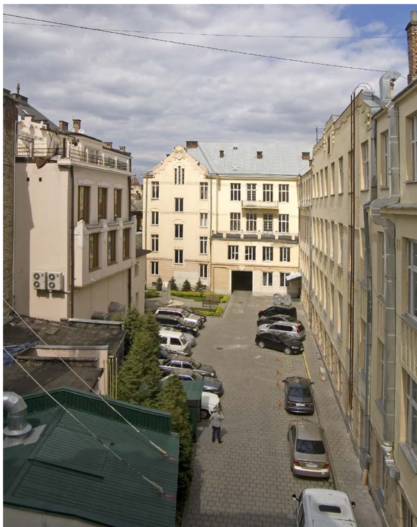
22. Tylne elewacje i dziedziniec Lwowskiej Izby Handlowo-Przemysłowej przy ul. Akademickiej 17–19 oraz Instytutu Technologicznego przy ul. Bourlarda 5 we Lwowie. Fot. I. Żuk
