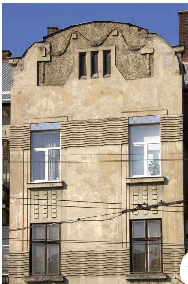
21. Kamienica Mrozowickich przy ul. Jabłonowskich 44 we Lwowie, elewacja. Zespół form późnosedecyjnych. Fot. I. Żuk
