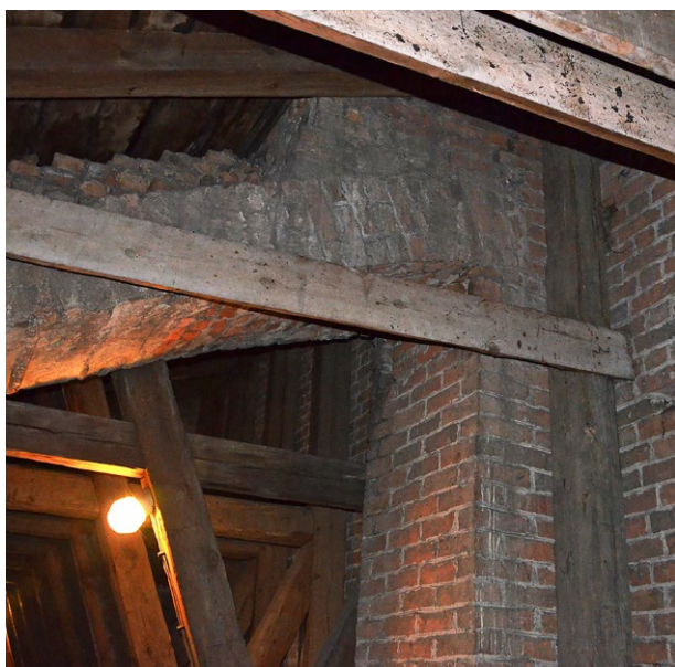
6. Włocławek, katedra pw. Wniebowzięcia NMP, strych nad nawą południową, łuk oporowy. Fot. P. Pajor
