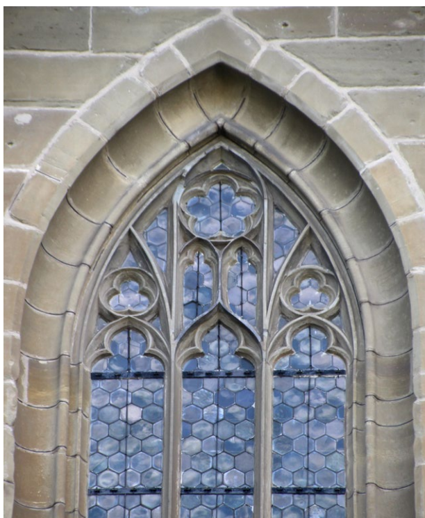
22. Salem, kościół opactwa Cystersów, maswerk okna w północnej ścianie prezbiterium. Fot. J. Adamski
