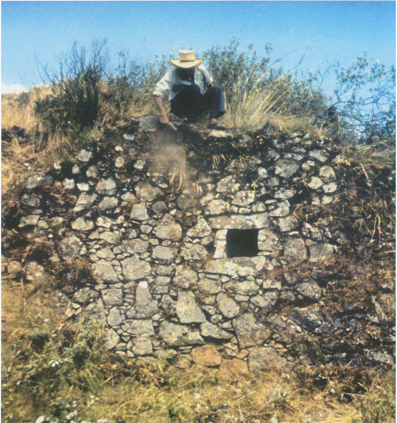
Fig. 17-1. Muro de terraza con nicho en el sitio AC-17.
