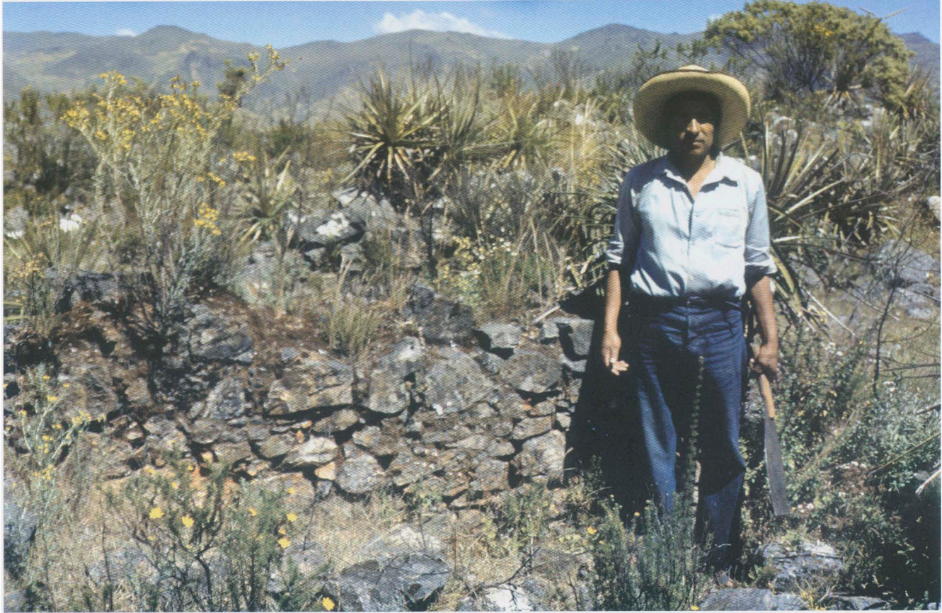
Fig. 14-1. Paredes de viviendas en el sitio AC-14.
