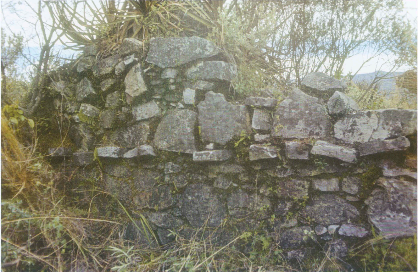
Fig. 63-4. Cerro El Redondo (AC-63). Interior de una vivienda con hilera de soportes de piedra clavados en la pared.
