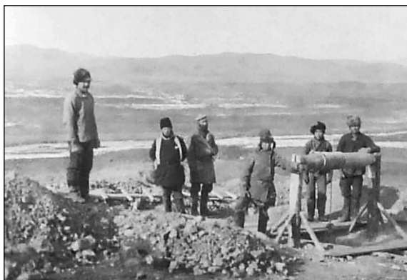
Ryc. 9. Opróbowanie złoża fluorytu na górze Bukuka, fot. S. Doktorowicz-Hrebnicki (Zdanowski, Rejman 2010, s. 41)
