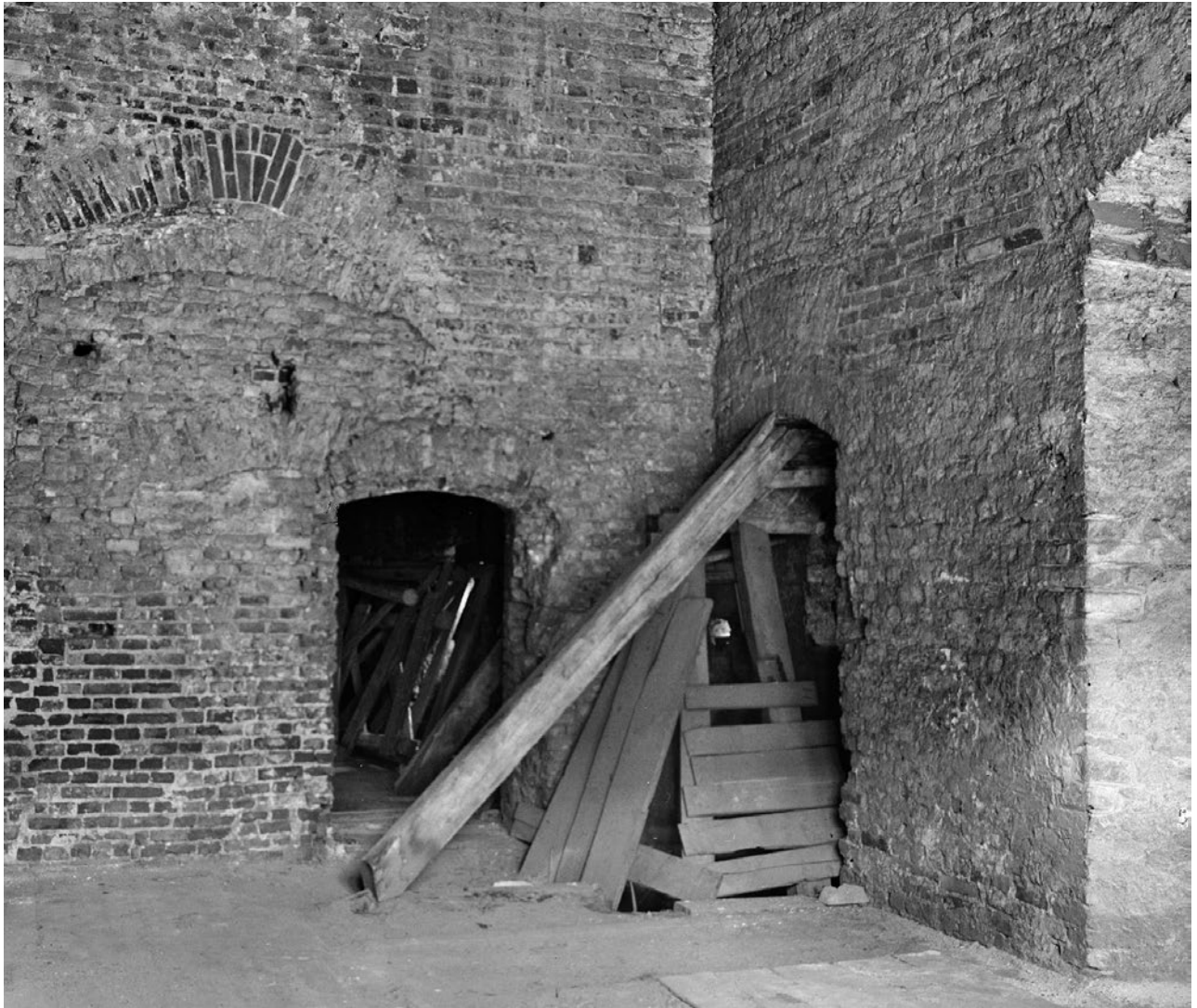
1. Narożnik północno-zachodni sieni II piętra nad bramą (116), stan w 1936. W ścianie północnej (prawej) widoczny oryginalny łęk nad dawną wnęką w murze
