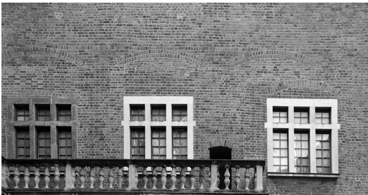
2. Elewacja zachodnia wielkiej sieni-komnaty królowej w skrzydle zachodnim (119), stan obecny. Nad trzema oknami widoczne trzy regularnie rozmieszczone łęki; bezpośrednio przy oknie południowym (prawym) czwarty łuk odciążający oraz ślad po zamurowaniu lewego segmentu otworu, a także wtórne wejście na schody kręcone
