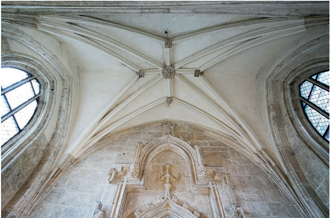
13. Kraków, kościół św. Katarzyny na Kazimierzu, sklepienie kruchty. Fot. M. Maślanka
